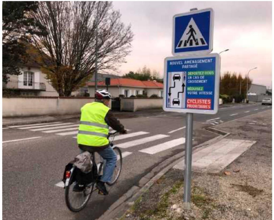
Testée rue Jean-Goujon, la voie centrale à chaussée banalisée ou chaus-sidou sera mis en place avenue des Martyrs-de-la-Résistance. c.g.
